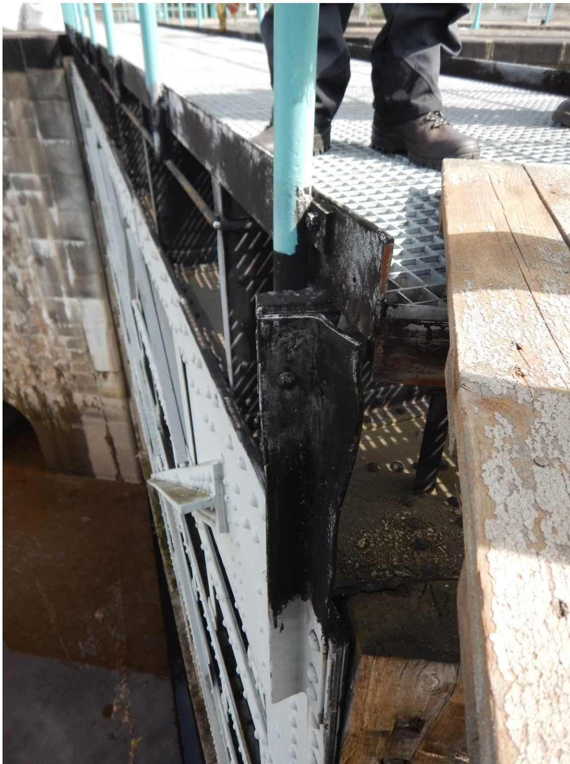
Obr. 3: Pohled na poškození krajního nosníku lávky v místě srazu vrat
